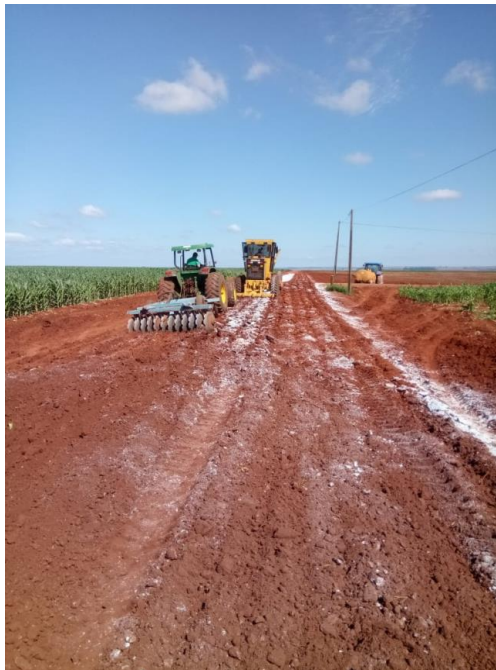
Figura 3: Incorporação do produto na camada de 20 cm
