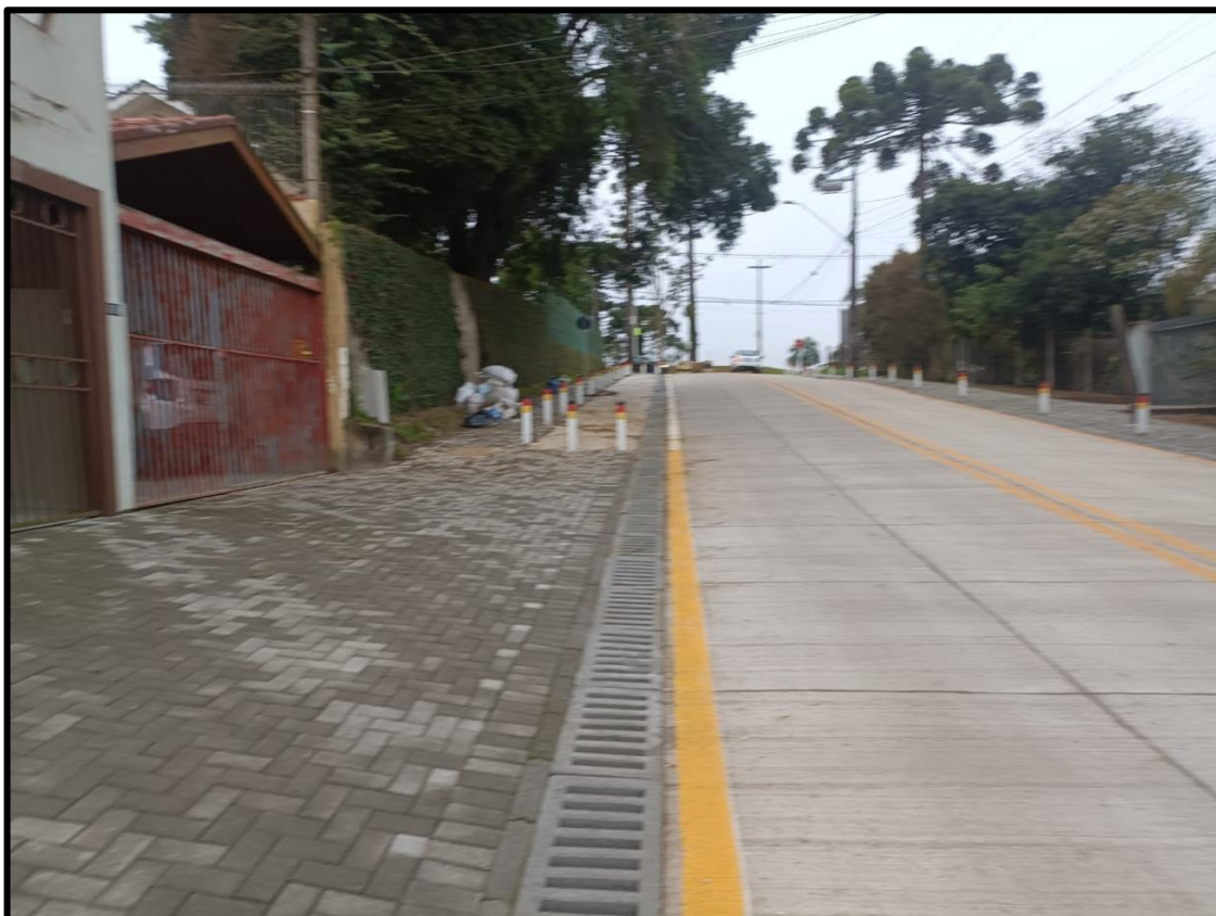
Na foto a cima ilustra como vai ser a canaleta com grelha em concreto no pavimento Whitetopping.
